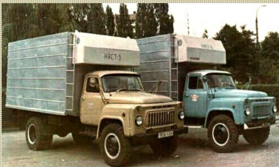
Авторефрижераторы с азотной системой охлаждения
